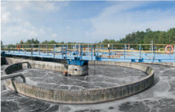
Wasseraufbereitungsanlage, Quelle: envato elements
