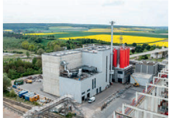
Mono-Klärschlammverbrennungsanlage, Quelle: EEW
