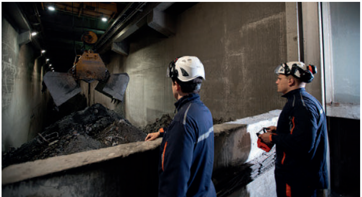
Schlackenbunker, Quelle: EEW
