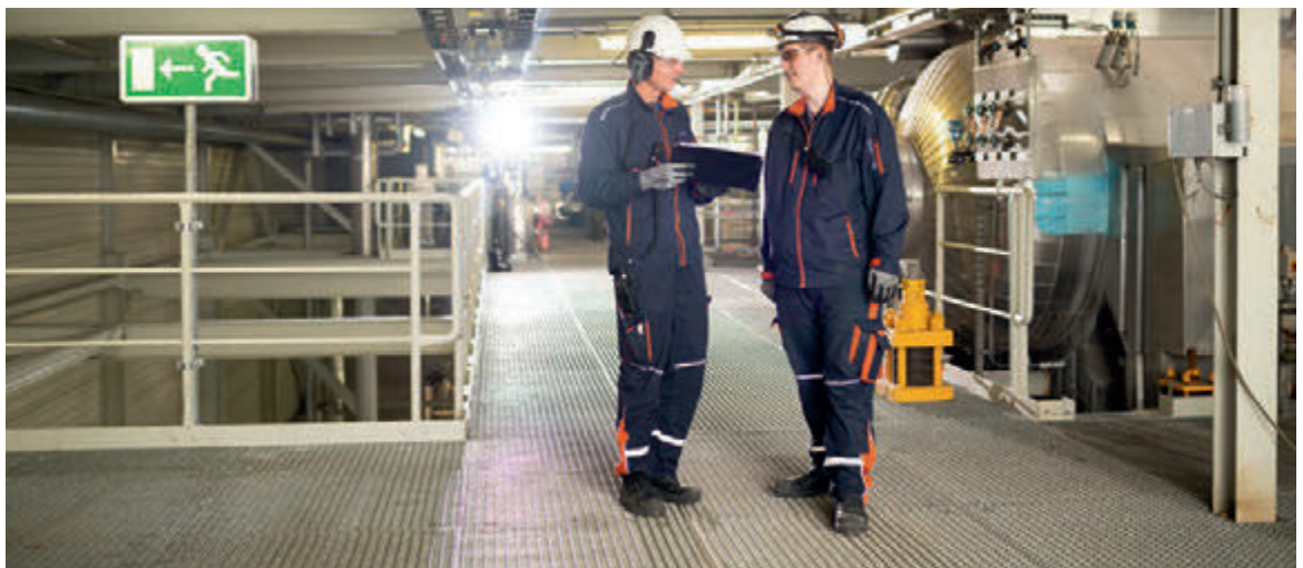
Mitarbeiter MVA Delfzijl, Quelle: EEW
