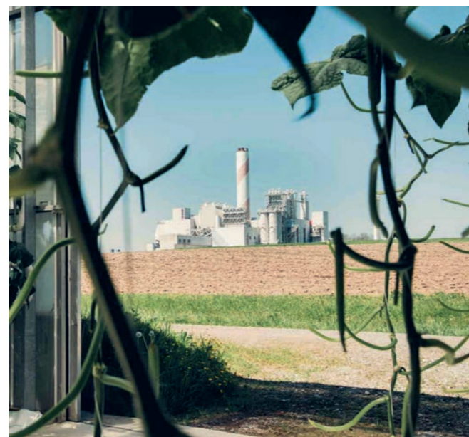
Die Müllverbrennungsanlage Hinwil des Zweckverbands Kehrichtverwertung Zürcher Oberland (KEZO) nutzt Kohlendioxid als Dünger
