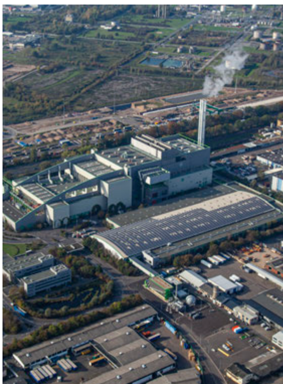
Müllverbrennungsanlage, Quelle: AVG Köln
