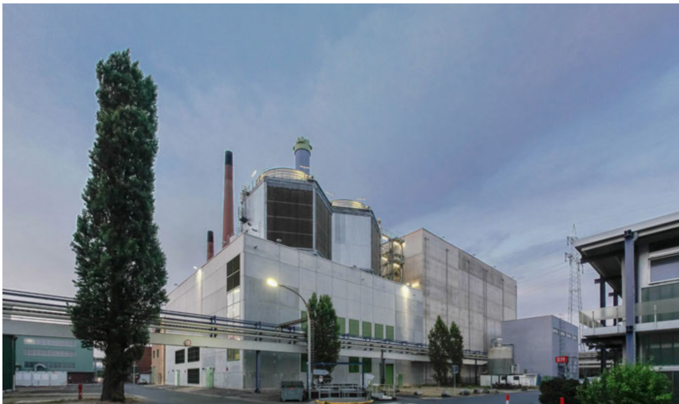
IHKW Andernach, Quelle EEW
