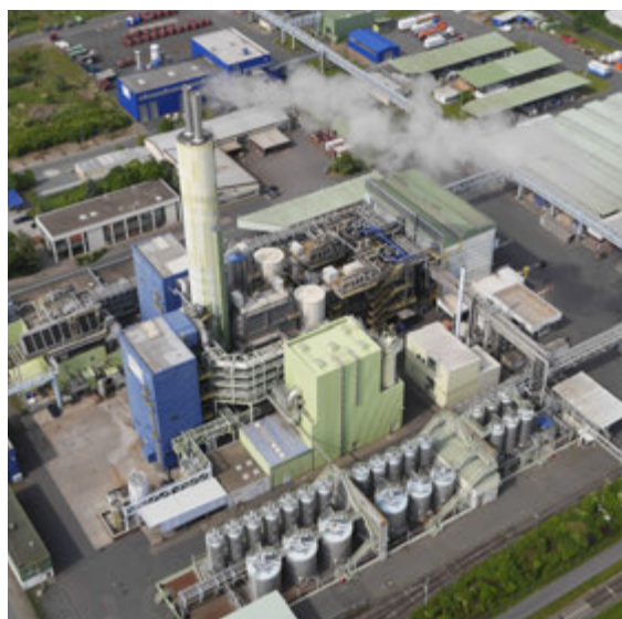
Sonderabfallverbrennungsanlage mit Lagertanks, Quelle: HIM
