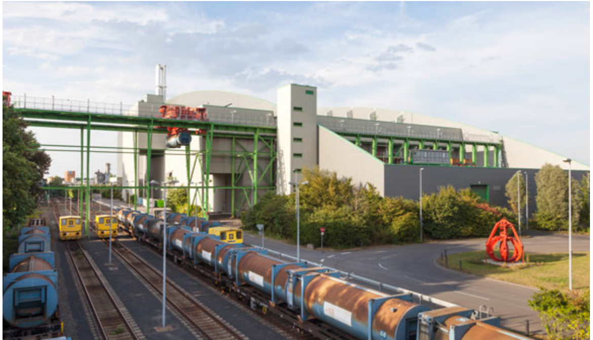
Anlieferung von Abfällen via Schiene einer MVA, Quelle: AVG Köln
