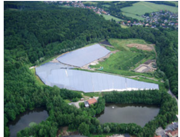
Deponienachsorge mit Photovoltaik, Quelle: Abfallbeseitigungs-GmbH Lippe
