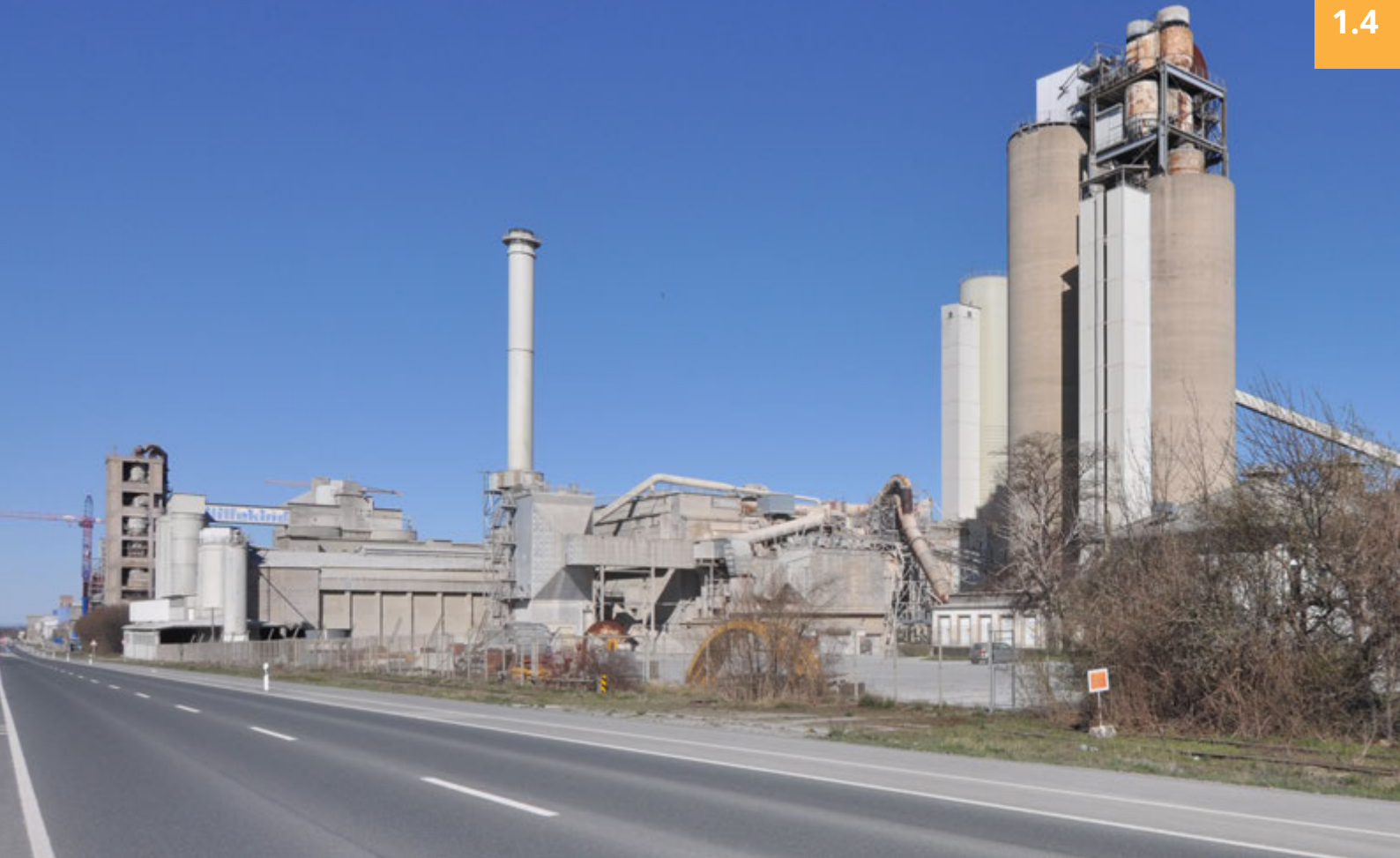
Energetische Nutzung von nicht verwertbaren Abfällen in Zementwerken, Quelle: Breer
