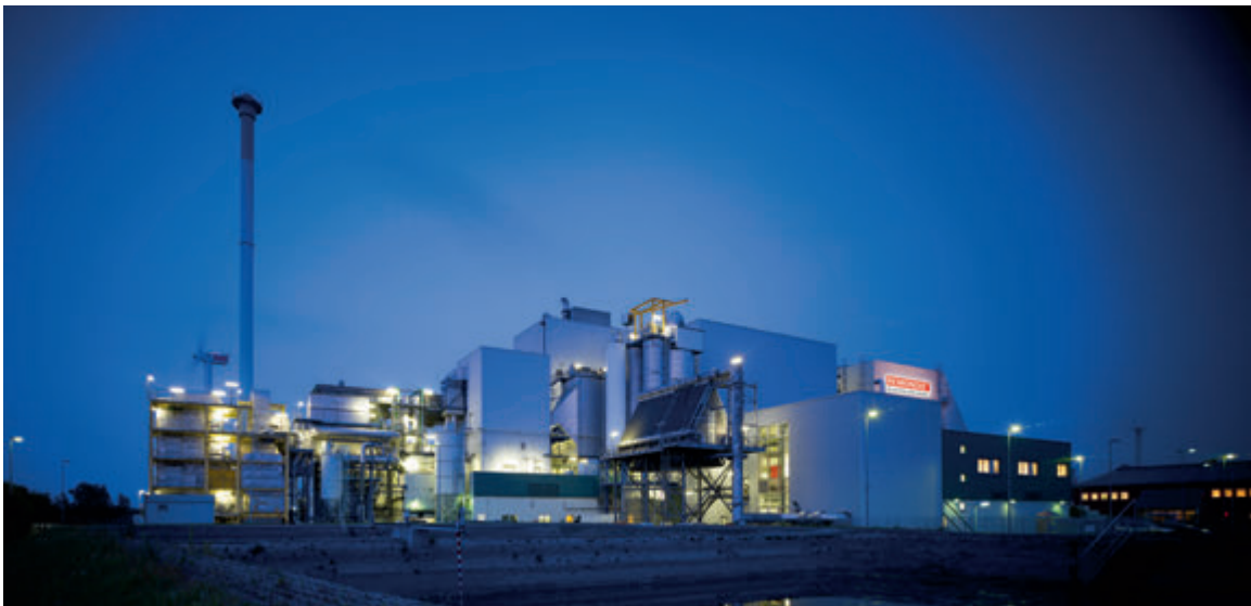
Sonderabfallverbrennungsanlage: Durch Behandlung Zerstörung von gefährlichen Substanzen, Quelle: REMONDIS
