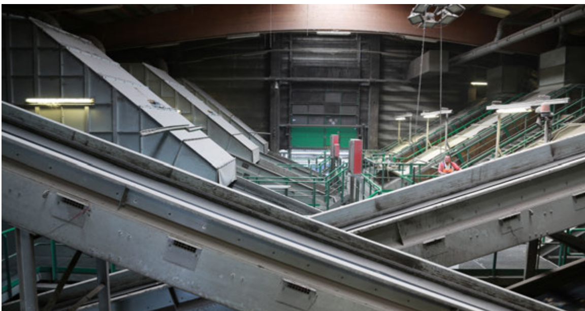
Sortieranlage einer MBA, Quelle: ECOWEST
